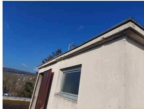
Exemple de reprises béton BÂT 22
