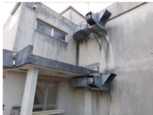
Gaines extérieures + extracteurs de désenfumage chambres Bât 22
